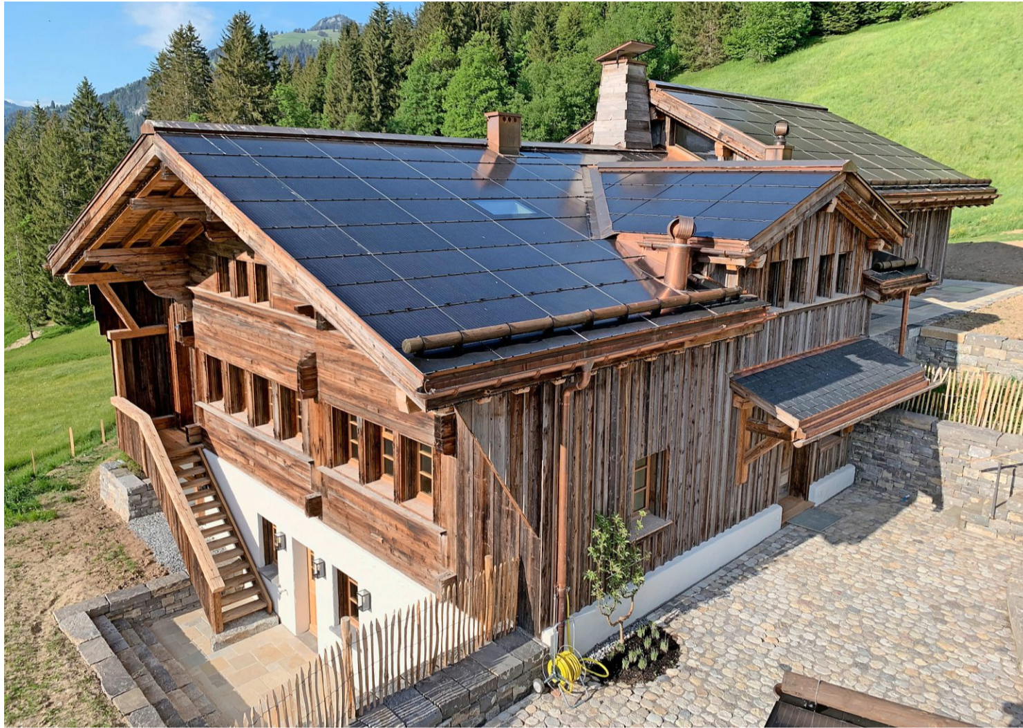
Solarmodule, Spezialglas und Dachfenster, alles made in Berner Oberland. Eine Indach-Solaranlage, erbaut von der Firma Solar-Up. Foto: PD
