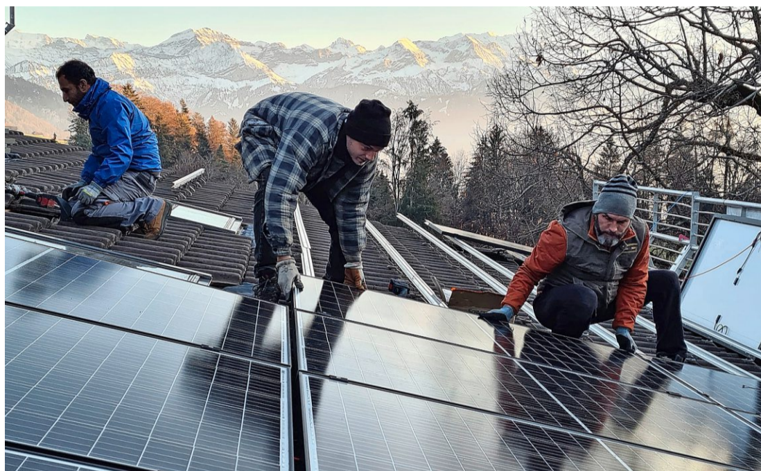
Mitarbeiter der Energie Genossenschaft Schweiz installieren Solarpanels auf dem Dach des Landgasthofs Rothorn in Schwanden ob Sigriswil. Foto: Hans Peter Roth
